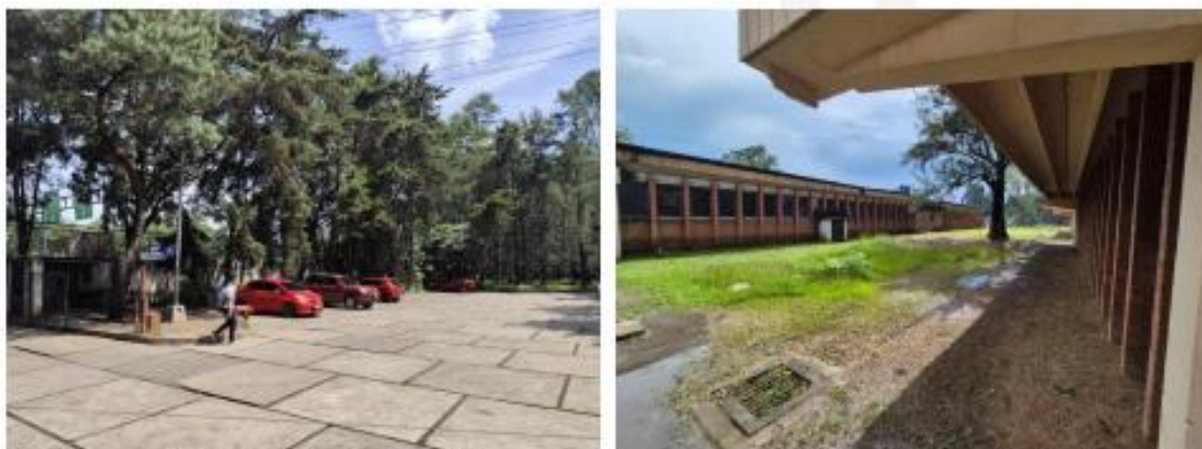
Imagen 10, 11, 12 y 13. Servicios básicos: S.S. mujeres y hombres, iluminación, alumbrado eléctrico en estacionamiento, alcantarillado. Fuente: CGP
