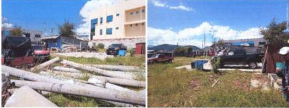
Foto 11 y 12. En el terreno se encuentran construcciones informales In situ: un piso de concreto, dos bodegas de lámina y una pila.
