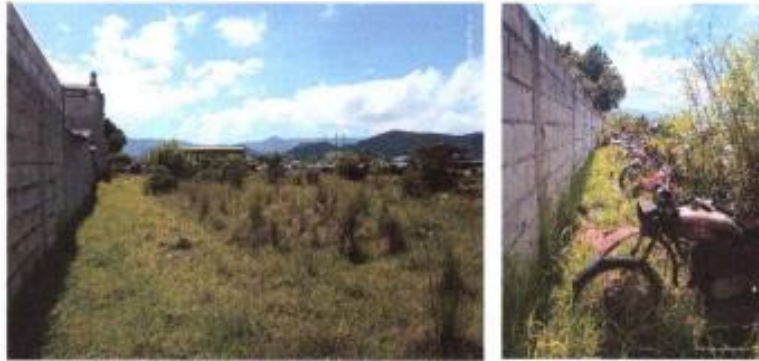
Foto 13 y 14. El polígono del terreno se encuentra delimitado por un muro perimetral con marcos de concreto armado y mampostería de block en el lado norte y oeste.
