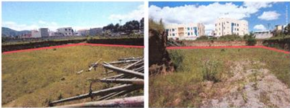
Foto 1 y 2. La línea roja marca los límites del área intervenida en trabajos de excavación, calculando aproximadamente 2,420 metros cuadrados .
