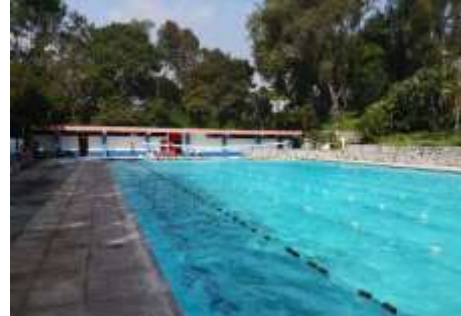
Ilustración 6 Piscina Instalaciones Deportivas, Ciudad Universitaria zona 12
