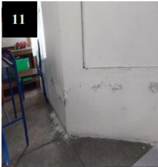
Fotografía No. 11 y 12, Filtración en losa por falta de mantenimiento y desprendimiento de acabados en paredes, derivado de la ocupación ilegal del Campus Central.
