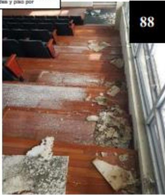
Fotografía No. 85, 86, 87 y 88, Desprendimiento de cielo falso en Edificio, deterioro en las paredes y piso por
