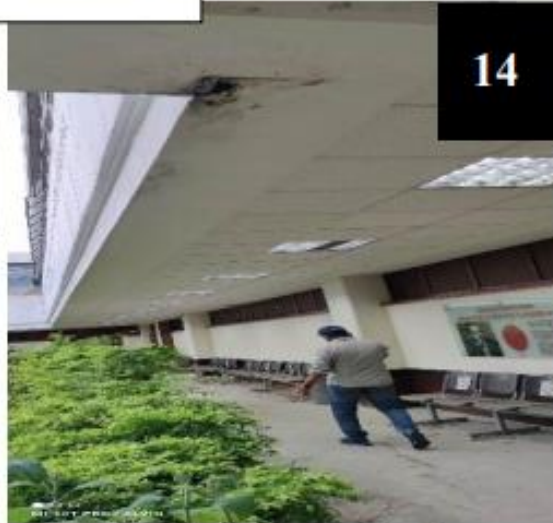
Fotografía No.11,12,13 y 14, se puede observar el deterioro del cielo falso en todo el edificio.
