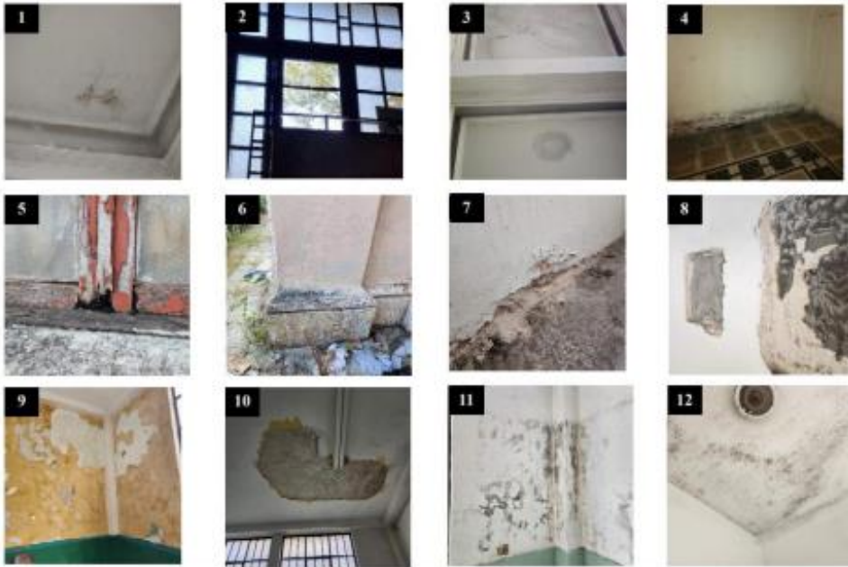
1) Techo con filtración de humedad, Odontología. 2) Ventana con vidrio quebrado, Odontología. 3) Techo con filtración de agua, Odontología. 4) Muro con deterioro en base por humedad, Odontología. 5) Ventana con marco dañado, Odontología. 6) Columna con grietas entre espacios, Odontología. 7) Muro con deterioro en base por humedad, Odontología. 8) Muro con perforaciones de ratos, Odontología. 9) Muro con deterioro de yeso, Odontología. 10) Muro con deterioro de yeso, Odontología. 11) Techo con deterioro de yeso, Odontología. 12) Muro con grietas y filtración de humedad, Odontología.
