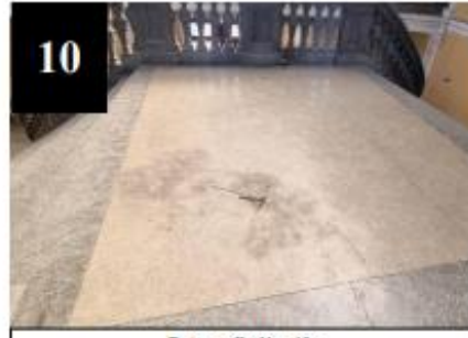
Fotografía No. 10: Las gradas de acceso al segundo nivel muestran signos de deterioro y fisuras de magnitud significativa
