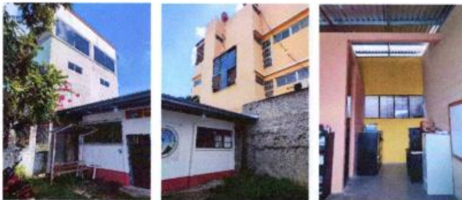
Foto 15, 16 y 17. Ventanas en el muro de la fachada principal y posterior del inmueble Fuente: CGP
