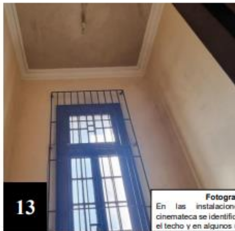
Fotografía No. 11 y 12: En el techo sobre las gradas de ingreso al segundo nivel en el vestíbulo principal exhibe condiciones de humedad y deterioro, y una ligera acumulación de cañite cañite
