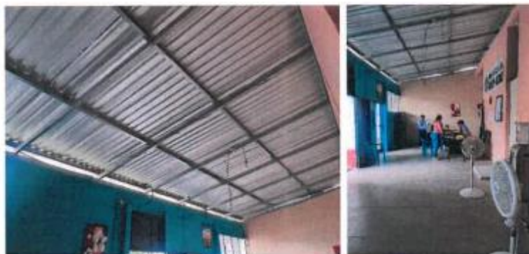
Foto 8 y 9. Cubierta de lámina y estructura metálica Fuente: CGP
