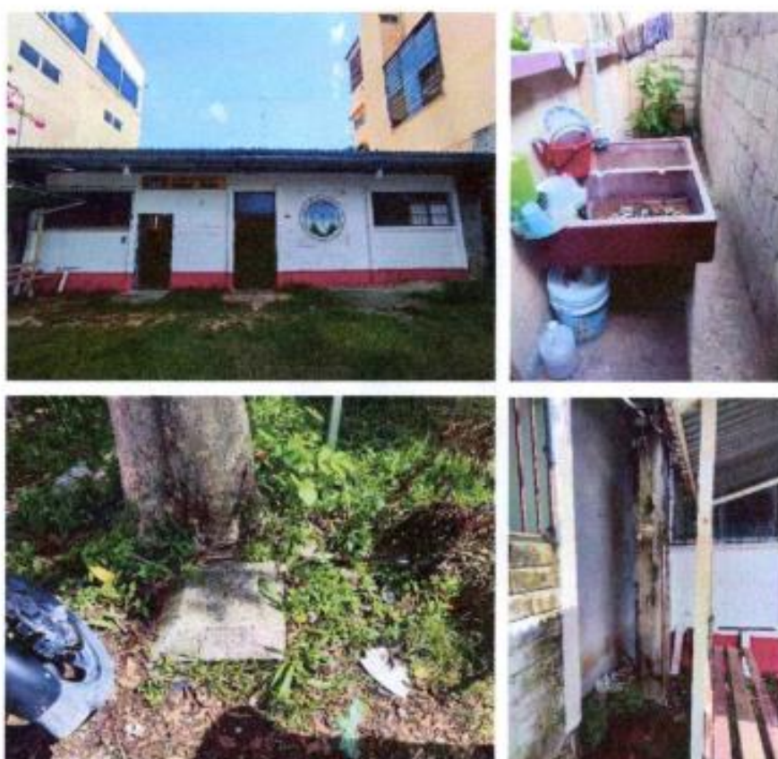
Foto 18, 19, 20 y 21. Iluminación exterior, pila, caja de drenajes y contador electricidad Fuente: CGP
