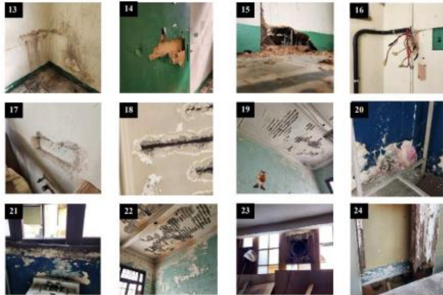
13 Muro con moho y humedad. Odontología. 14 Pared con pintura. Odontología. 15 Pared de división dañada. Odontología. 16 Cables eléctricos expuestos. Odontología. 17 Muro con perforaciones de agua. Odontología. 18 Techo con desperdicio de papel y concreto. Odontología. 19 Techo con desperdicio de papel y concreto. Odontología. 20 Muro con perforaciones de agua. Odontología. 21 Muro deteriorado sobre estanca de ventana. Odontología. 22 Techo con desperdicio de papel y concreto. Odontología. 23 Muro con moho y humedad. Odontología. 24 Techo con desperdicio de papel y concreto. Odontología.
