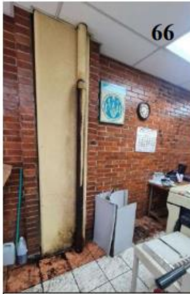
Fotografía No.66, Deterioro en las bajadas de agua en el edificio M-4
