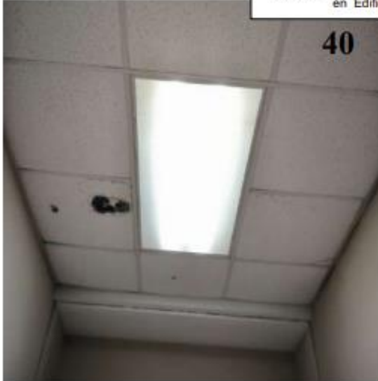
Fotografía No. 38,39,41 y 41. Cielo falso removido en todos los niveles y en mal estado por humedad, presencia de moho en Edificio DIGA.
