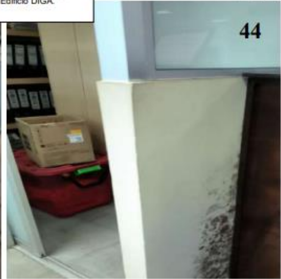
Fotografía No. 41, 42, 43 y 44. Muros internos con moho y en mal estado por humedad en Edificio DIGA.
