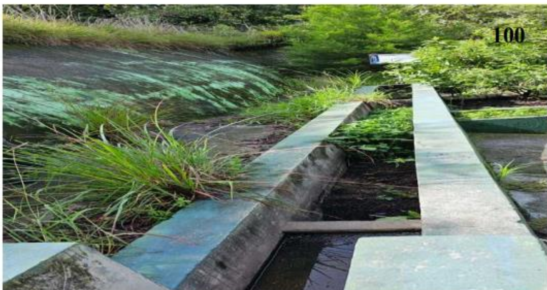
Fotografía 100 , muestra otra vista del canal de entrada que muestra la cantidad de arena que azolva al mismo.
