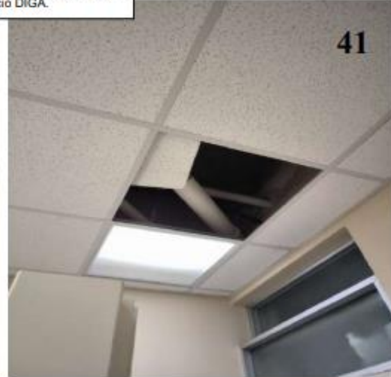
Fotografía No. 38,39,41 y 41. Cielo falso removido en todos los niveles y en mal estado por humedad, presencia de moho en Edificio DIGA.
