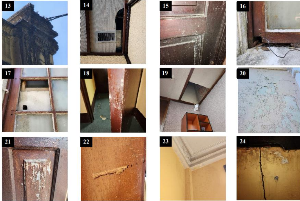
13) Fachada con daño en repello por agua, Radio USAC. 14) Cielo falso con daño, Radio USAC. 15) Puerta con moho, Radio USAC. 16) Ventana con perforación en marco, Radio USAC. 17) Ventana sin vidrio, Radio USAC. 18) Alfombra con daño, Radio USAC. 19) Cielo falso con daño, Radio USAC. 20) Muro con desprendimiento de pintura, Radio USAC. 21) Puerta con desprendimiento de barniz, Radio USAC. 22) Puerta con polla, Radio USAC. 23) Techo con filtración de humedad, Radio USAC. 24) Ventana con filtración de agua, Radio USAC.
