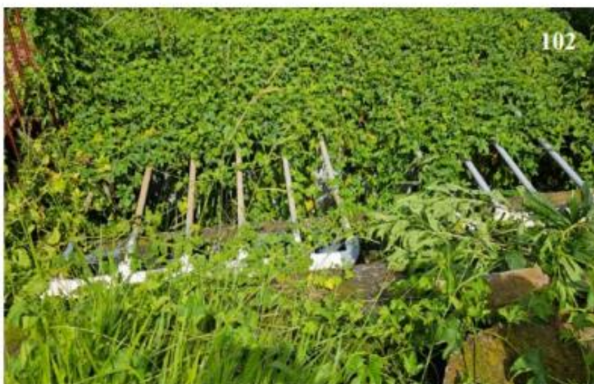
Fotografía 102 , Segunda batería de filtros. Nótese el crecimiento de la maleza sobre los lechos filtrantes y que será necesario podar para dejar libres a los lechos filtrantes en mención. En similares circunstancias se encuentra la tercera batería de filtros.
