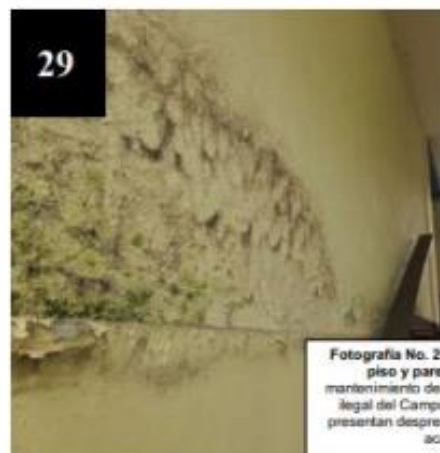
Fotografía No. 27 y 28. Deterioro del piso y paredes por falta de mantenimiento derivado de la ocupación ilegal del Campus Central.
