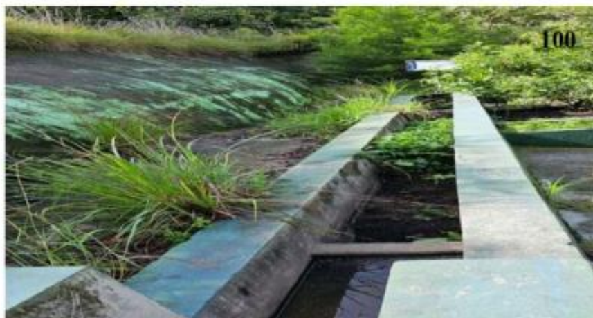
Fotografía 100 , muestra otra vista del canal de entrada que muestra la cantidad de arena que azolva al mismo.
