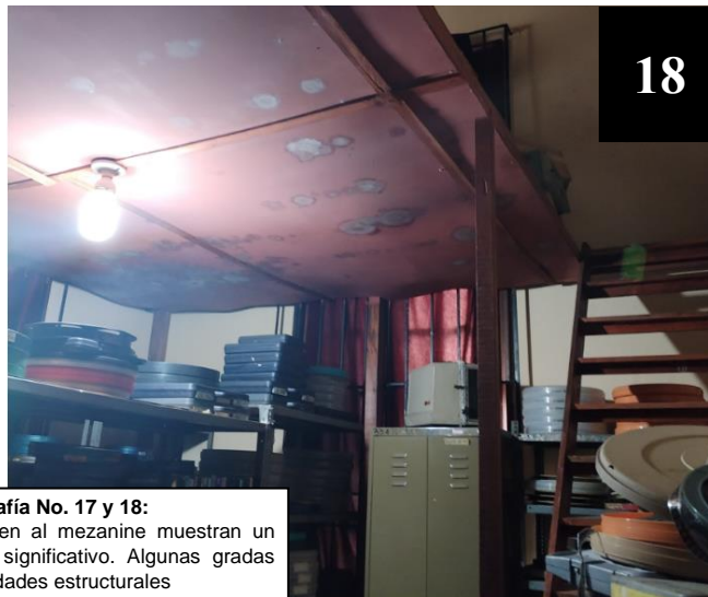
Fotografía No. 15 y 16: En el área de mezanine de madera, destinada al almacenamiento de cintas cinematográficas se identificaron múltiples problemas que generaron el deterioro del mismo, tales como: la presencia de moho, salitre, pando y filtraciones en el techo y muros
