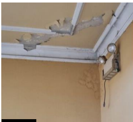
Fotografía No. 11 y 12: En el techo sobre las gradas de ingreso al segundo nivel en el vestíbulo principal exhibe condiciones de humedad y deterioro, y una ligera acumulación de salitre
