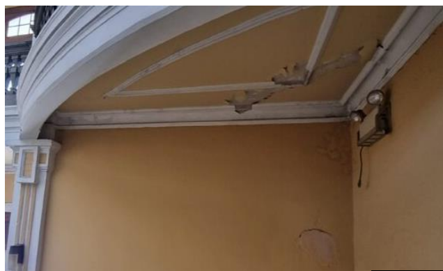
Fotografía No. 11 y 12: En el techo sobre las gradas de ingreso al segundo nivel en el vestíbulo principal exhibe condiciones de humedad y deterioro, y una ligera acumulación de salitre
