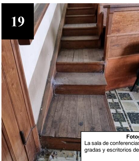
Fotografía No. 17 y 18: Las gradas que suben al mezanine muestran un estado de deterioro significativo. Algunas gradas presentan vulnerabilidades estructurales
